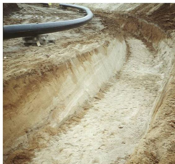
*Abb. 11 Gasleitungsgraben in der Aue bei Köln: Der ausstreichende Bv-Horizont im Vordergrund zeigt den Abtrag einer Kuppe an. Mit dem Boden wurde die Materialentnahmegrube im Hintergrund verfüllt.
