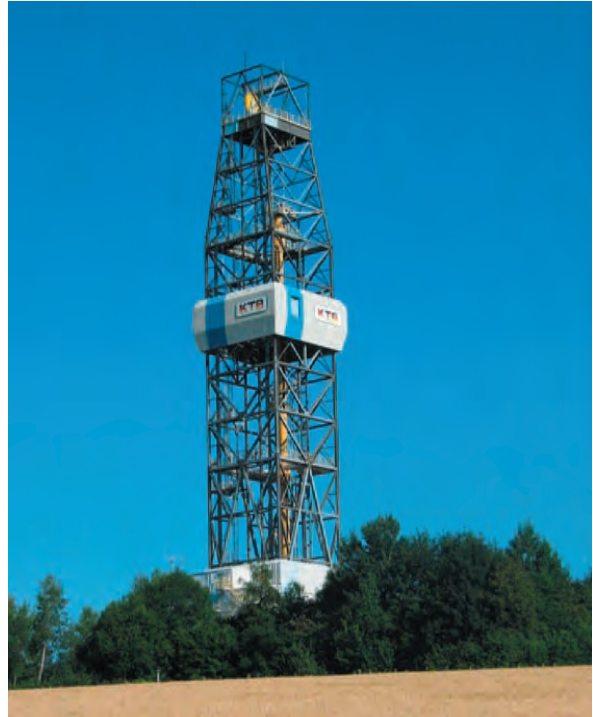
Abb. 40. Bohrturm der Kontinentalen Tiefbohrung KTB bei Windischeschenbach.
